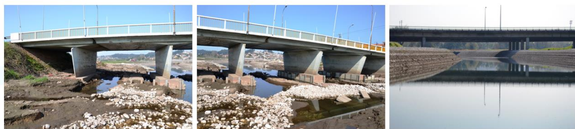
Figura 28 - Obras de consolidação da base da ponte de Campo e aspeto do canal já construído.
