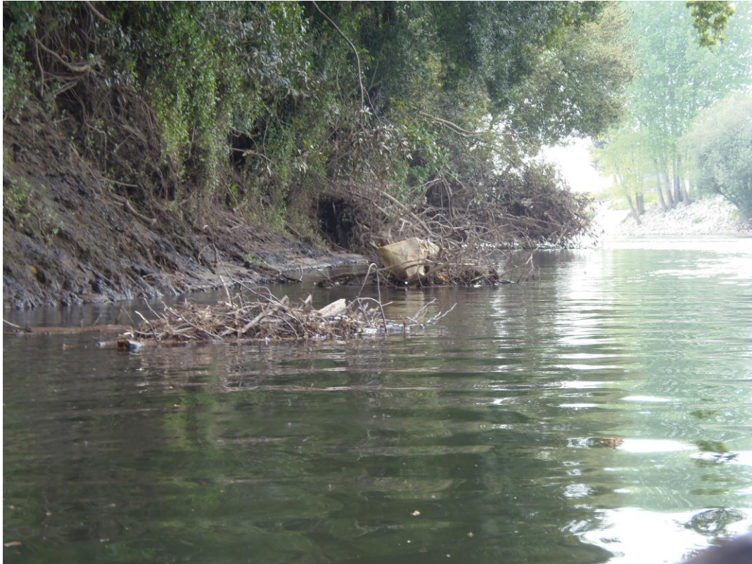
Figura 19 - Aspeto da margem esquerda a jusante onde se acumulam detritos e lixo e com a galeria perturbada.
