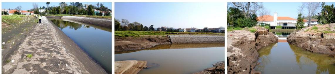
Figura 27 - Zona da ligação a realizar entre o canal e o rio a jusante.
