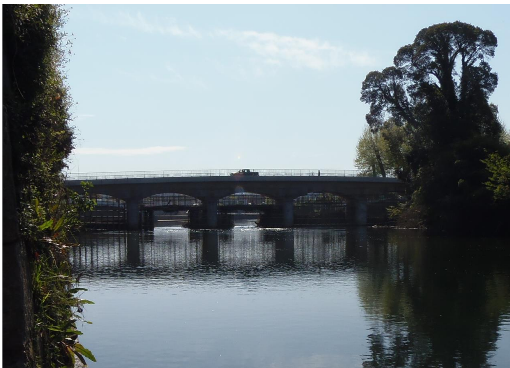
Figura 15 - Aspeto da Área de estudo na ponte sobre o Rio Águeda, sendo de destacar a estrutura de obra que dificultava a vazão e promovia a acumulação de detritos (ramos de árvore, lixo).
